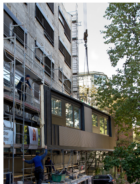
Bilder oben: Montage der vorgefertigten Fassadenelemente in der beengten innerstädtischen Situation am Münchner Rotkreuzplatz Bild unten: Detailansicht oberer Elementanschluss; Befestigung am Bestand mit Stahlwinkeln - Buchenholzdübel, auf die das nächste Element „aufgesteckt“ wird.
