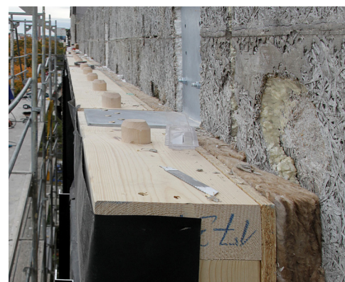
Bilder oben: Montage der vorgefertigten Fassadenelemente in der beengten innerstädtischen Situation am Münchner Rotkreuzplatz Bild unten: Detailansicht oberer Elementanschluss; Befestigung am Bestand mit Stahlwinkeln - Buchenholzdübel, auf die das nächste Element „aufgesteckt“ wird.
