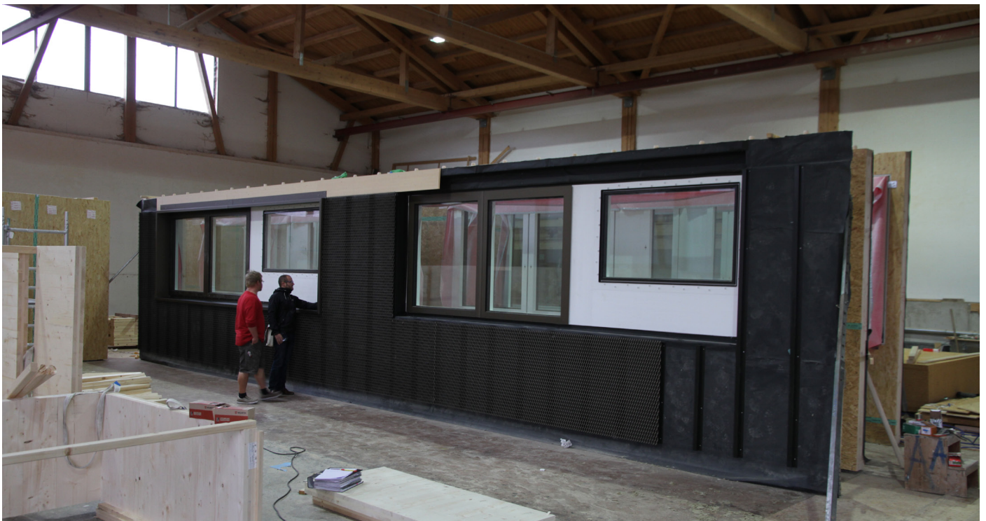
Oben und unten: Vorfertigung der Fassadenelemente einschl. Fenster, Raffstorenhalterung und Bekleidung im Werk
